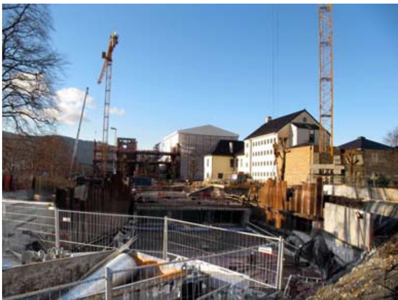
T.v. Statsarkivet i Bergen i januar 2011. På den vestlige delen av det nye magasinbygget ble dekket støpt før jul, mens arbeidet med den østlige delen fortsatt pågår. Bak i bildet reiser det nye odontologibyget seg. Foto: Tom Myrvold.
