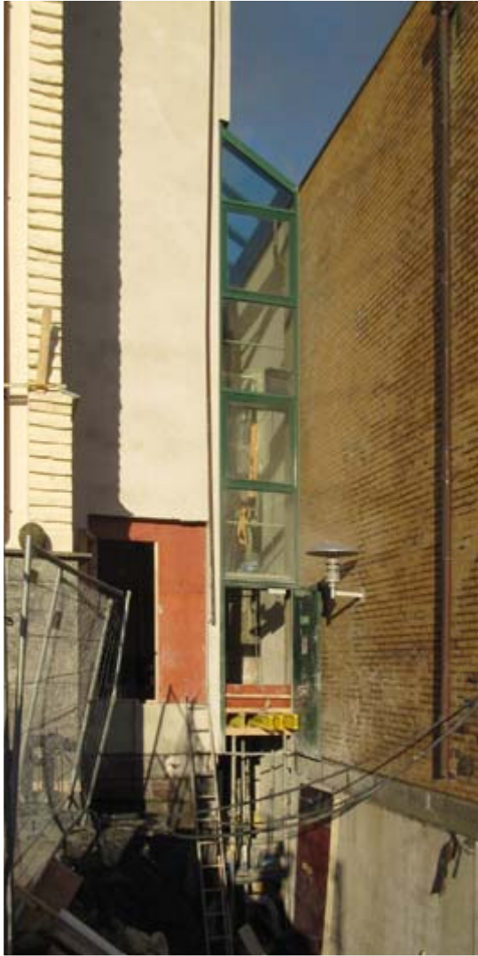
Over: Statsarkivet i Bergen januar 2011. «Mellombygget» fra 1993 skal bygges om. Alt over 3. etasje skal fjernes, og det skal etableres en friluftspassasje gjennom bygget over 1. og under 3. etasje. En «bro» i 3. etasje skal binde sammen 1921- og 1993-bygget. En ny forbindelse mellom disse to byggene og 2011-bygget skal oppføres på utsiden av og parallelt med 1993-bygget. Foto: Tom Myrvold.
